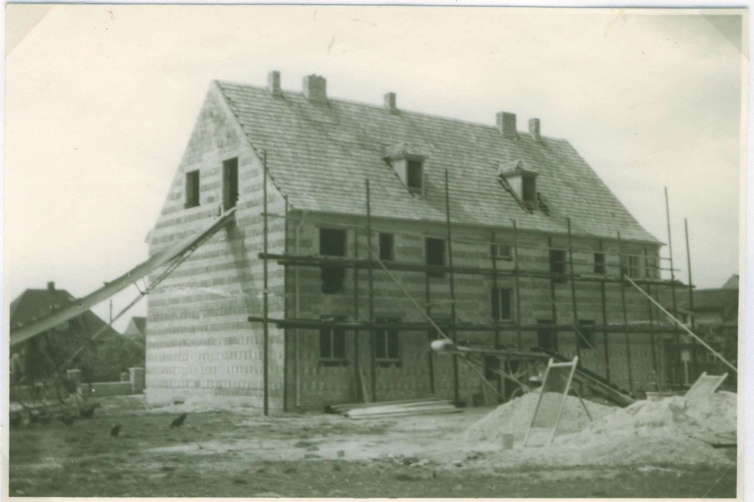
Rohbau des Gemeindehauses
