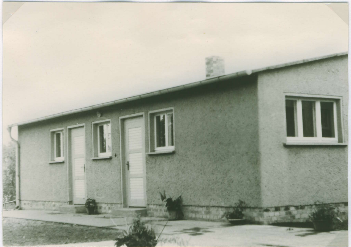
Sanitäreanlagen der Schule
