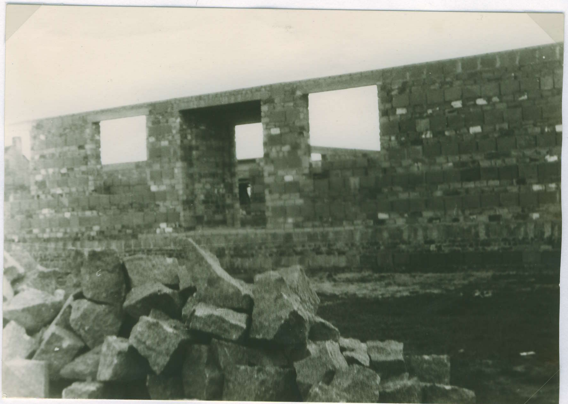
Baubeginn der Arztpraxis
