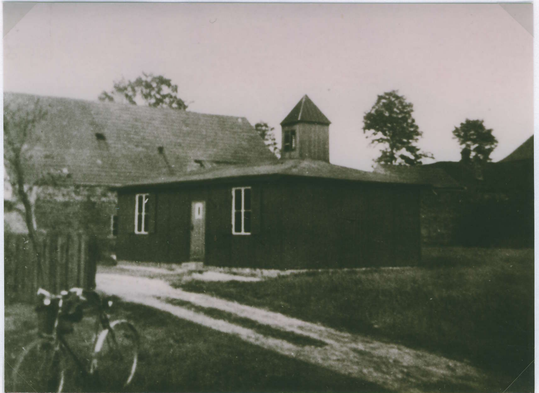
Die Martin -Luther-Kapelle wird als Holzhaus errichtet
