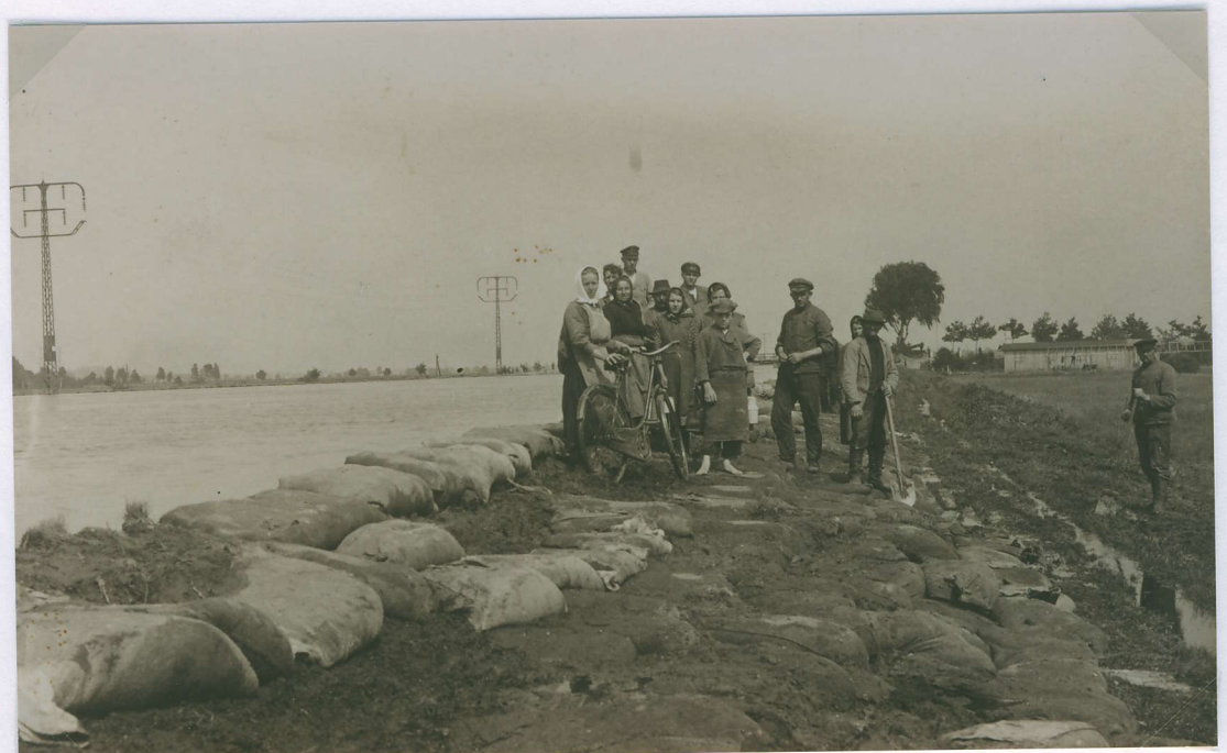
Sandsäcke sollen den Dambruch verhindern
