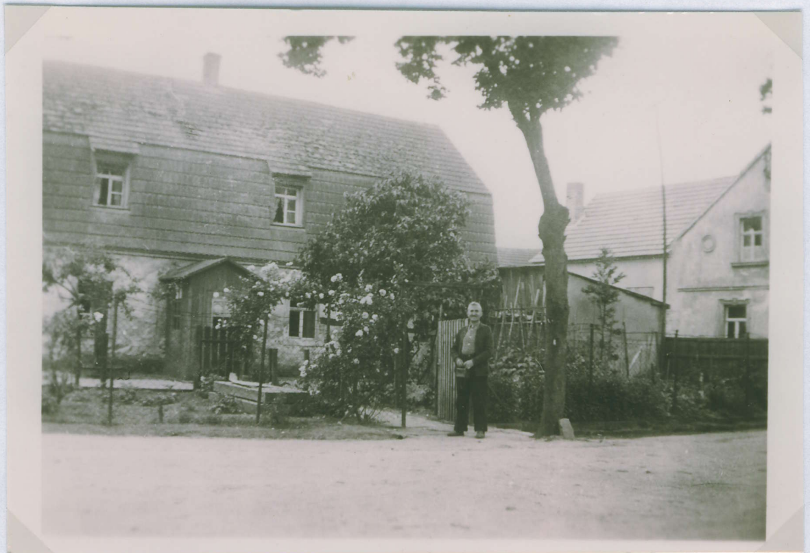
alte Schule mit neuem Dach
